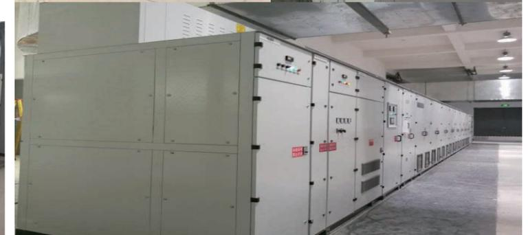
·西气东输某压气站10000kvar
